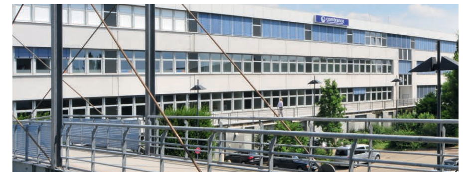
Die comtrance GmbH hat ihren Unternehmenssitz im Connecta Parc, Düsseldorf-Eller. Hier betreibt sie auch ein eigenes Rechenzentrum, basierend auf dem neuesten Stand der Technik.
